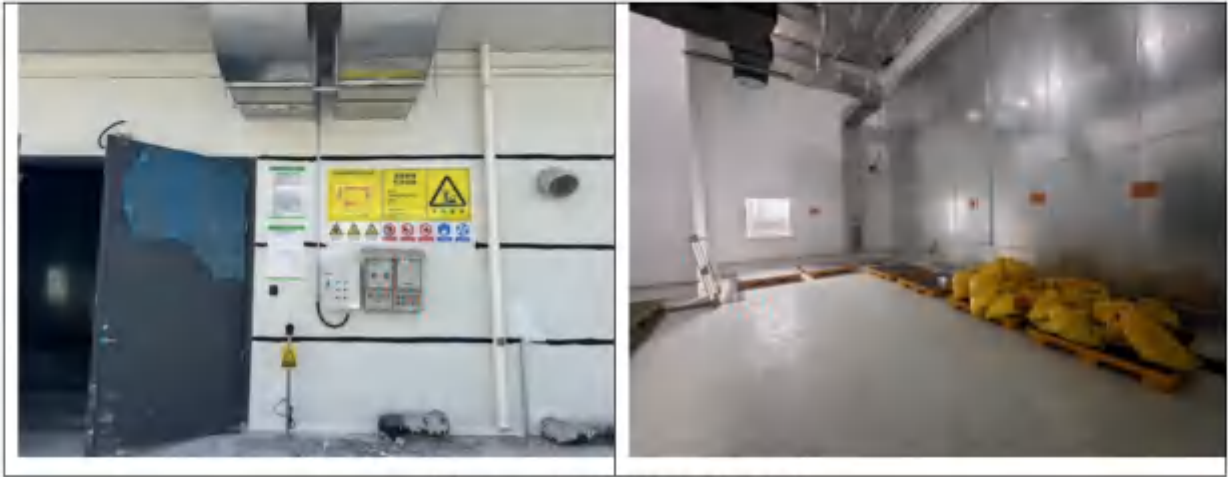
图 4.1-4 危废暂存间现场图
