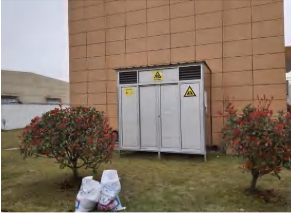
图 3.3-3 现有危废暂存间
