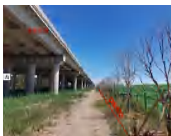
第 2 段管线走向实景（高速段）
