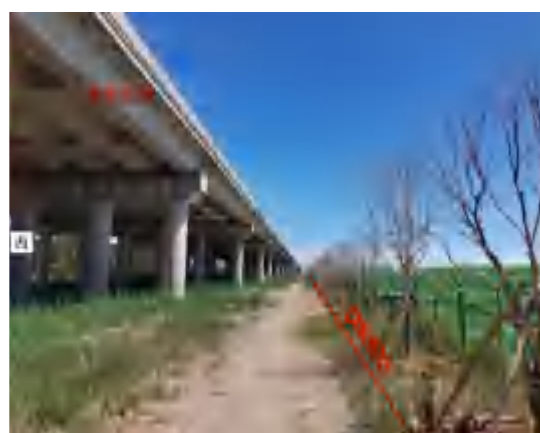
第 2 段管线走向实景（高速段）
