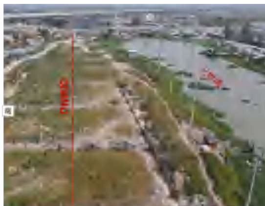
第 3 段管线走向实景（上望浦段）
