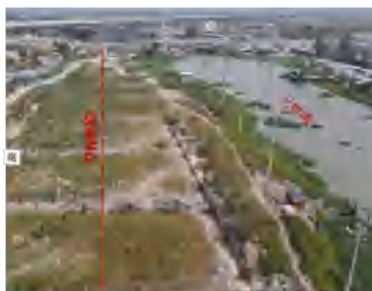
第 3 段管线走向实景（上望浦段）
