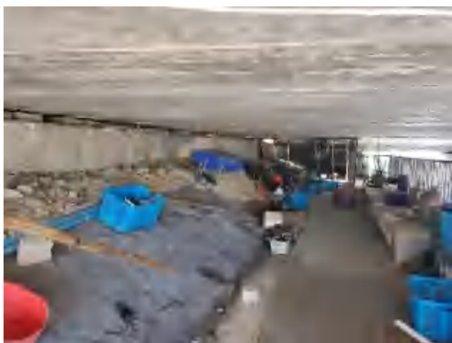
进港公路桥下实景
