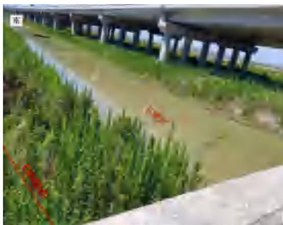
第 2 段管线走向实景（下塘河段）
