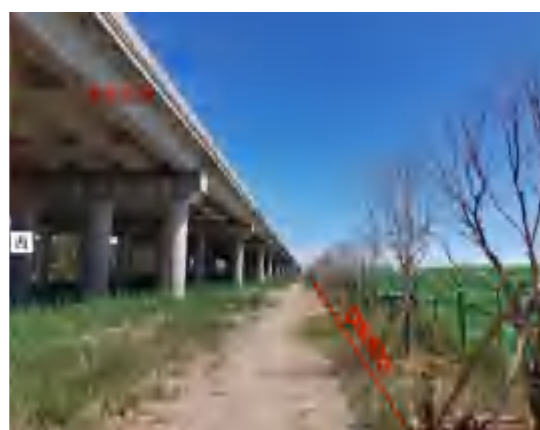
第 2 段管线走向实景（高速段）
