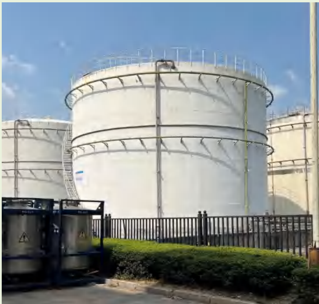
图 3.3-2 现有废水罐 3000m 3
