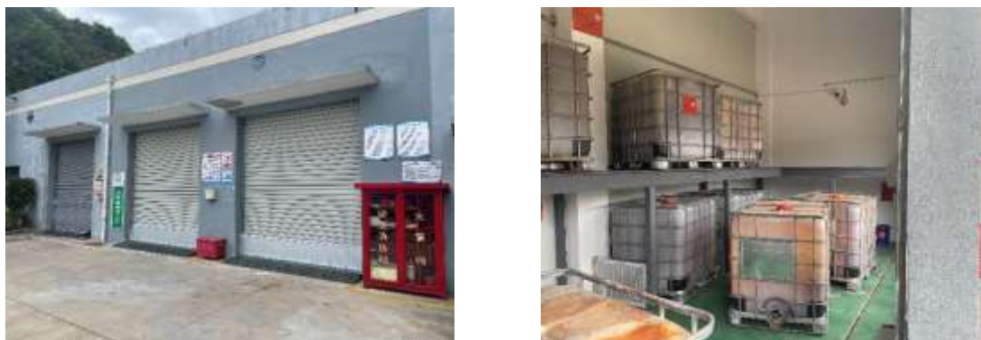
图 4-2 危废暂存车间图
