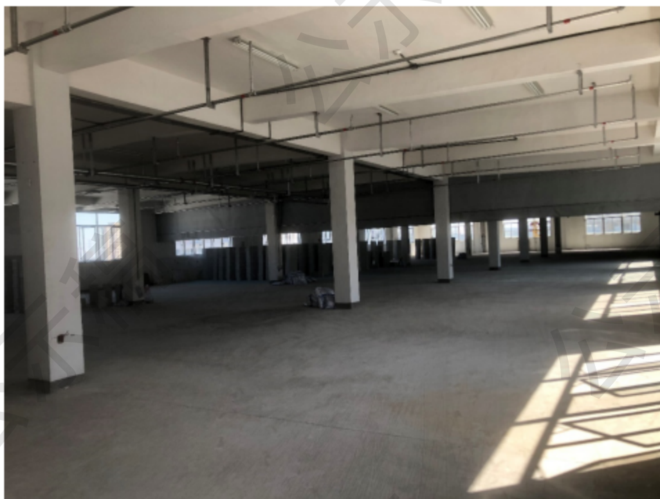
图 2-4 金源路 88 号 6# 厂房现场照片
